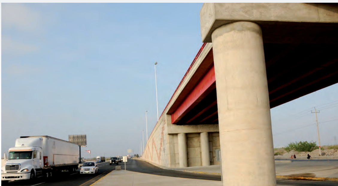
| Conclusión del paso a desnivel Santa María, Ramos Arizpe, Coahuila.
